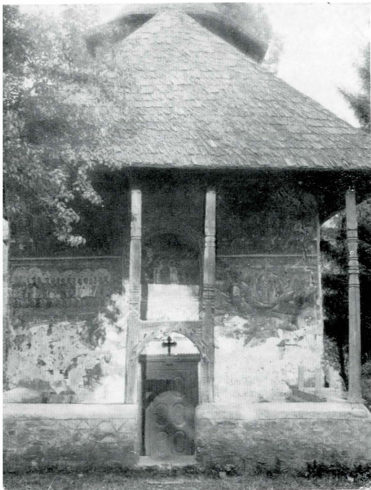
ig. 7. Fațada de vest, înainte de restaurare.
